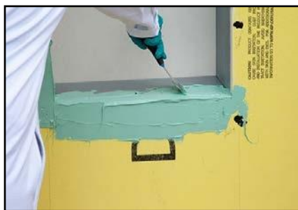
Figure 1: Application du solin de silicone liquide DOWSIL™ 778.
