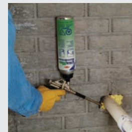
Traverses de tuyauterie
